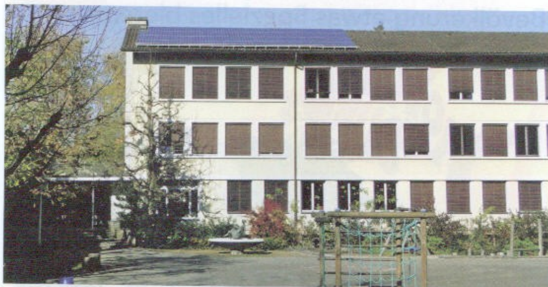
Alles Gute kommt von oben: Das Schulhaus Allmend nutzt die Sonne als Wärmequelle.
